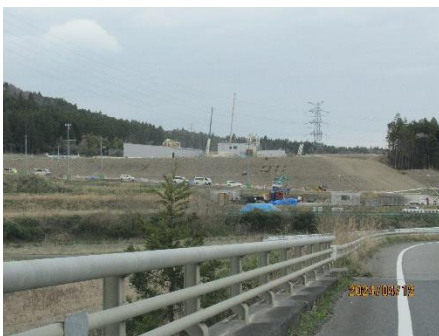
県道いわき浪江線沿い造成中
