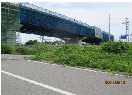
国道6号線高架橋工事
