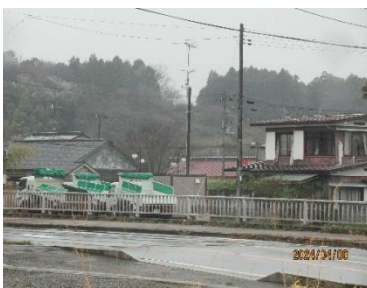
6号線沿い民家解体中
