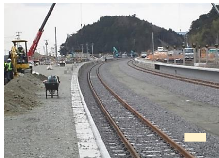
嵩上げされての敷設
