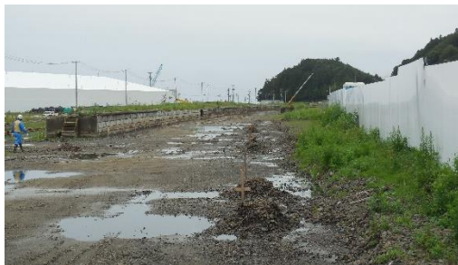
津波で流失した駅舎
