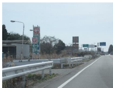
荒れ果てた国道6号線沿い
