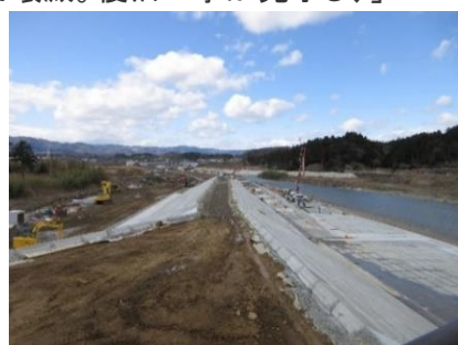
護岸工事始まる
