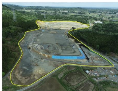
広大な工業団地 大手自動車 JOINT 決定
