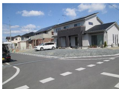
宅地造成後の住宅
