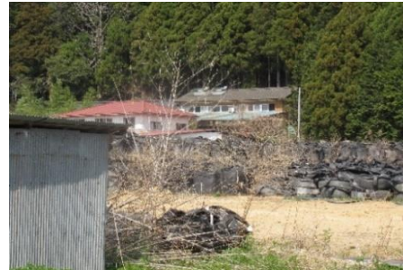
解体除染廃棄物山積み
