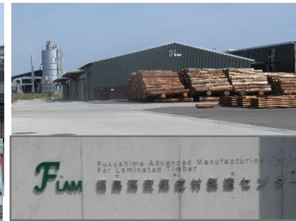
福島高度集成材製造センター
