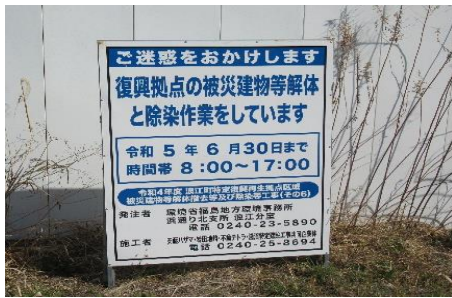
大堀地区解体・除染作業
