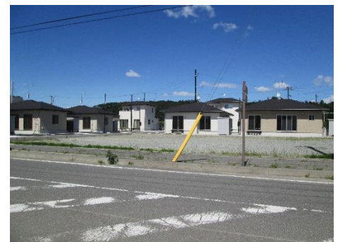
富岡町災害公営住宅
