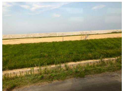
新たに築かれた防波堤（奥）と防風林苗木
