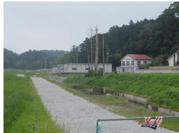
写真中央に枯れ木が数本立っている。津波に洗われ、その塩害のために立ち枯れした。
