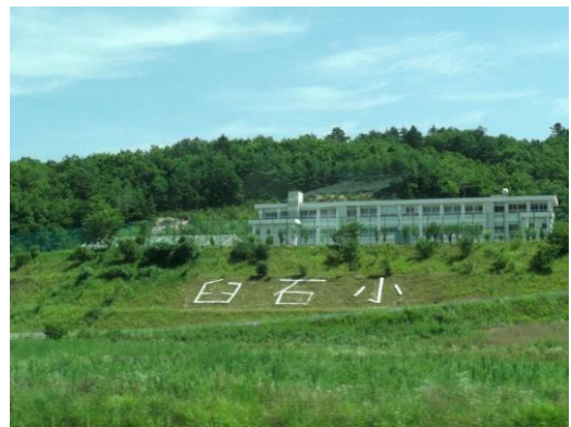
閉鎖されたままの白石小学校
