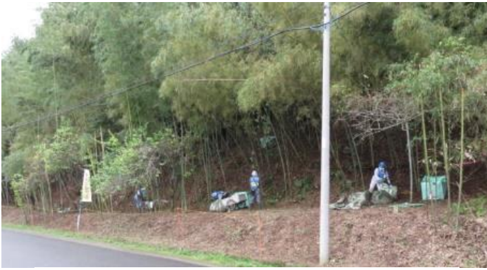
「除染作業中」の幟を立てての除染作業現場
