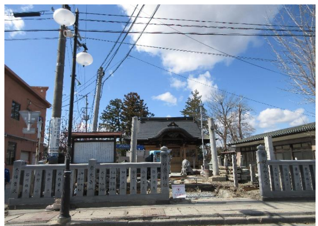
玉垣修復完了
