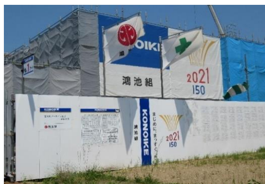
富岡町立アーカイブ施設 建設中
