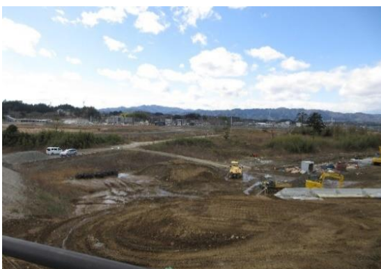
富岡漁港 復旧工事現場
