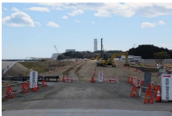
駅から国道6号線に向かう 架橋工事
