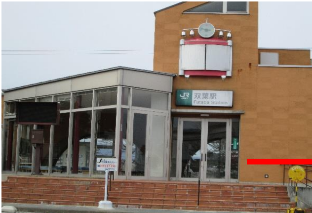
2017.2.20 双葉駅舎のみ復旧
