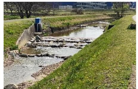
分散落差工による川の連続性を確保
