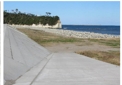
防潮堤 海側砂地
