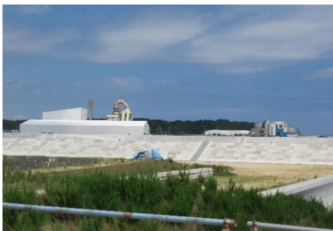
災害廃棄物焼却施設 分別施設
