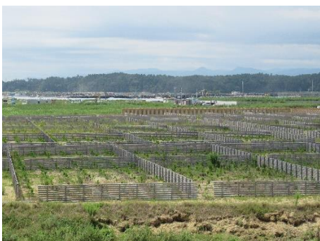
防潮林造成地先は更地が続く
