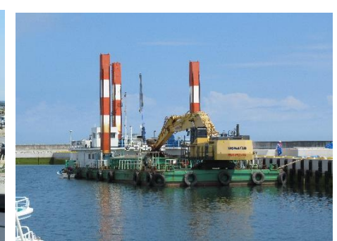
漁港内浚渫船作業
