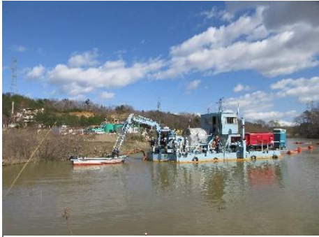
立野地区 溜池除染中
