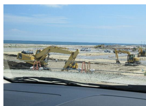
請戸海岸法面整備
