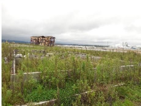
請戸地区建物壊滅
