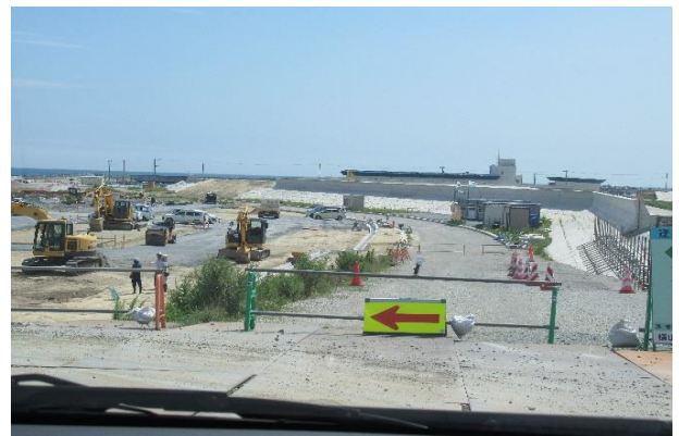
漁港への新たな道路工事
