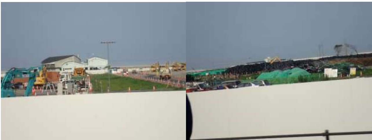
請戸小学校 将来は震災遺構 立ち入れず、遠目に見るだけ 周辺 除染廃棄物置き場
