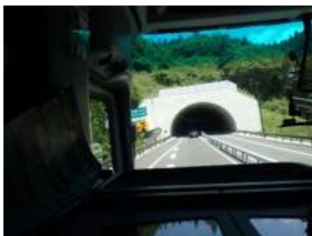
金弁蔵トンネル(626m)
