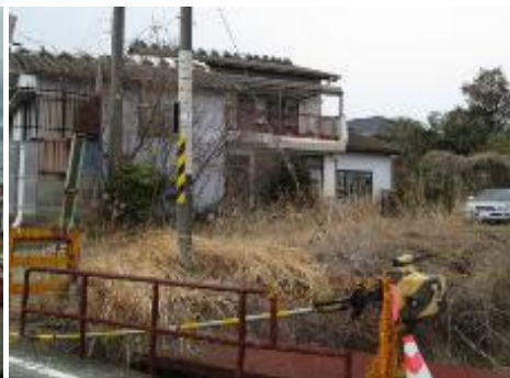
荒廃した双葉町
