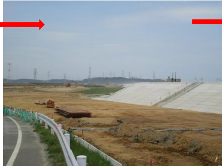
雫海岸防潮堤工事(2014.8.23)
