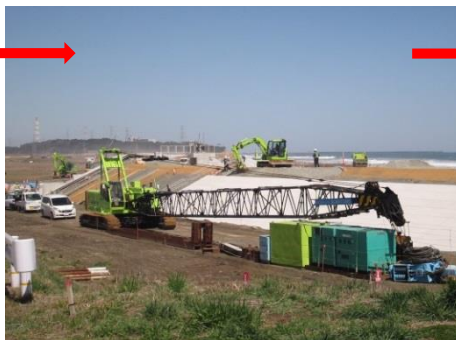
防潮堤復旧工事(2014.9.2)
