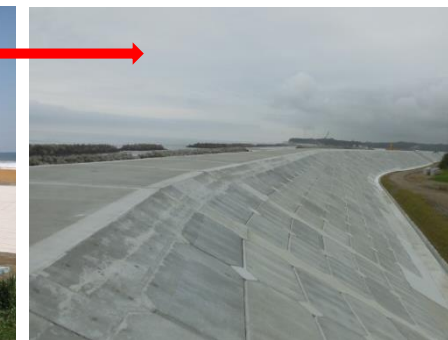
防潮堤ほぼ完成(2017.3.6)
